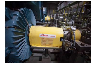
Moteurs électriques : 2 x 1600 kW + 6 x 600 kW
